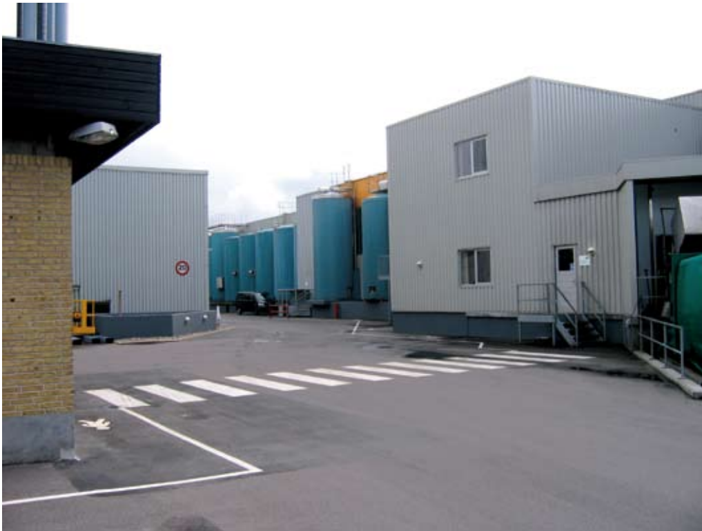
Markering af hvor gående må færdes udendørs.
